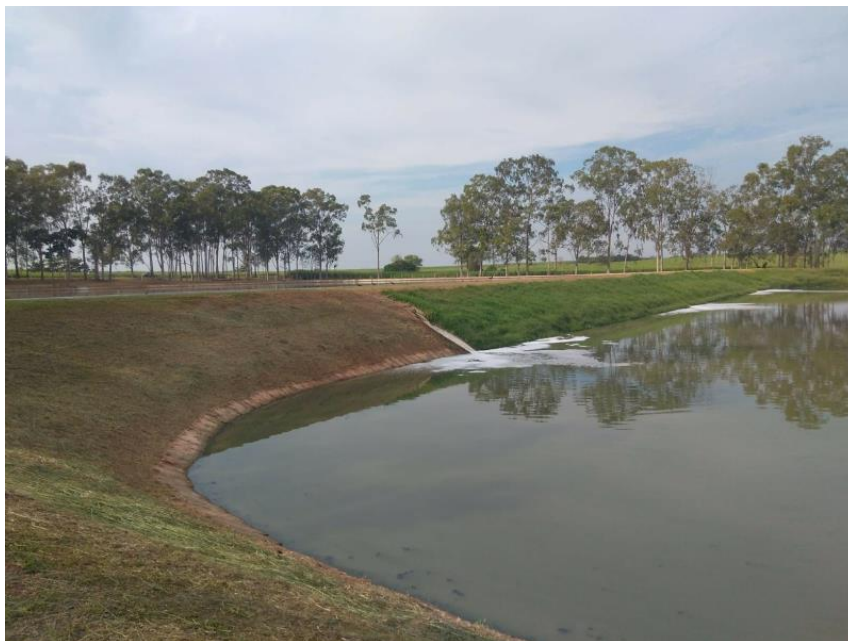
Figura 38: Tratamento preliminar na ETE
