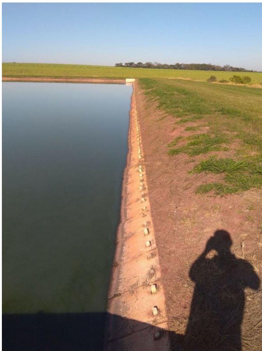
Figura 37: Tratamento preliminar na ETE
