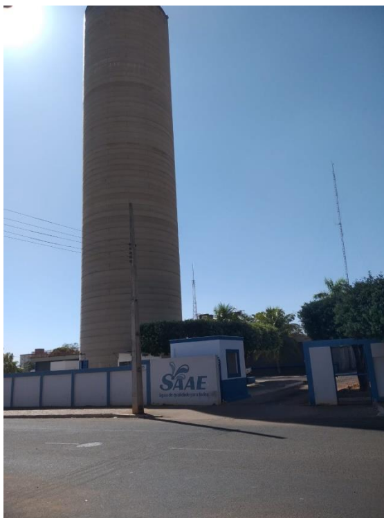
Figura 26: Estação de Tratamento de Água
