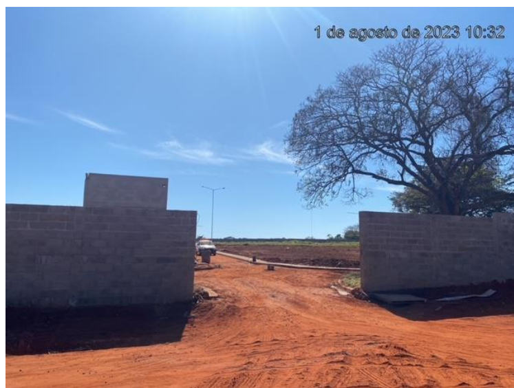
Figura 16: Vista geral da entrada principal.
