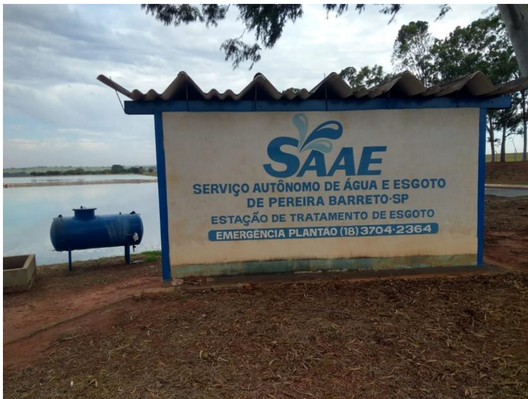
Figura 35: Placa de identificação da ETE
